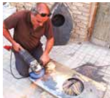
ساخت قسمت‌های فلزی Making the metallic sections
