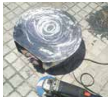
ساخت قسمت‌های فلزی Making the metallic sections
