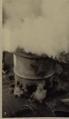
mergidas en la solución mencionada. El bizcocho cerámico se colocará rectamente en el tacho con la viruta de madera y leña, teniendo la precaución de no colocar otras piezas sumergidas en sulfatos, ya que éstas contaminarán a las otras por acción de atmósfera producida durante la quema. Para evitar ese problema generalmente trabajo con dos «tachos»: uno para piezas con sales (foto lado derecho) y otro para lograr blancos y negros (foto 1, lado izquierdo).
