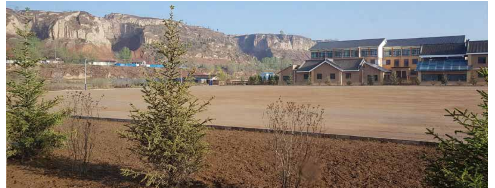
LINTAO KERAMISCH CENTRUM ACHTERZIJDE MET SLAAPKAMERS | LINTAO CERAMIC CENTRE BACKSIDE WITH OVERNIGHT ACCOMODATION
